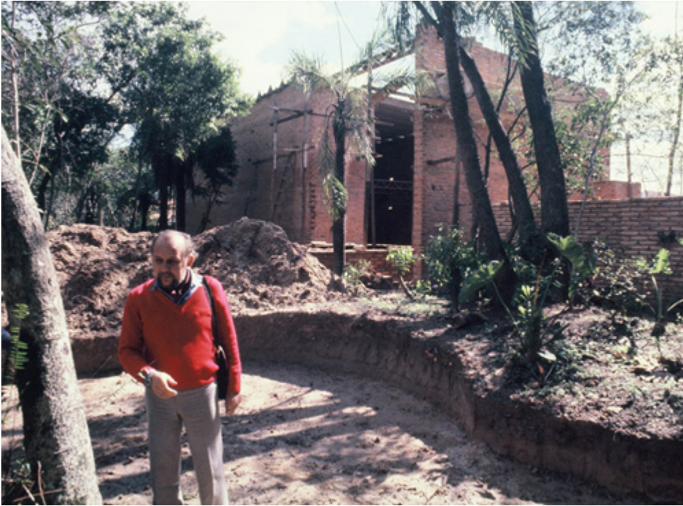
Carlos Colombino en la construcción de la Sala Josefina Plá en Isla de Francia.
