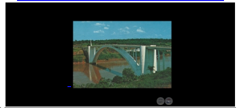
PUENTE INTERNACIONAL - PA...
