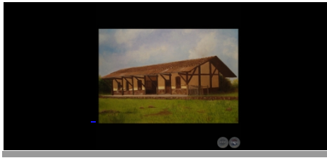
ESTACIÓN DE ITURBE - Obr...
