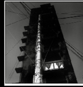
EDIFICIO - BARRIO SAJONIA...
